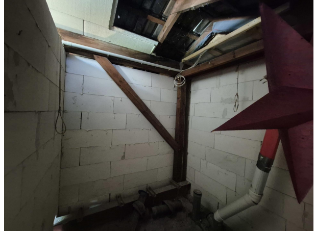
Raum für ein mögliches WC im DG
